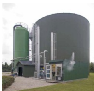
Figur 2. Diagram af opgraderingsenhed, der anvender amin vaskeproces; Foto af opgraderingsanlægget Hashøj, Danmark. Gaskapacitet 250 m 3 pr. time. (Kilde: Ammongas A/S).
