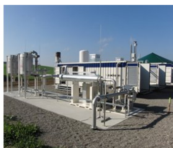
Figur 1. Diagram af opgraderingsenhed, der anvender membran-teknologi gasfiltrering; Foto af opgraderingsanlægget Kisslegg, Tyskland. Gaskapacitet 500 m 3 pr. time. (Kilde: AXIOM Angewandte Prozesstechnik).
